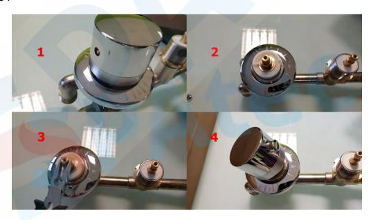
1. Retirer le bouchon plastique bleu et rouge du capuchon du robinet d'eau chaude/froide.
